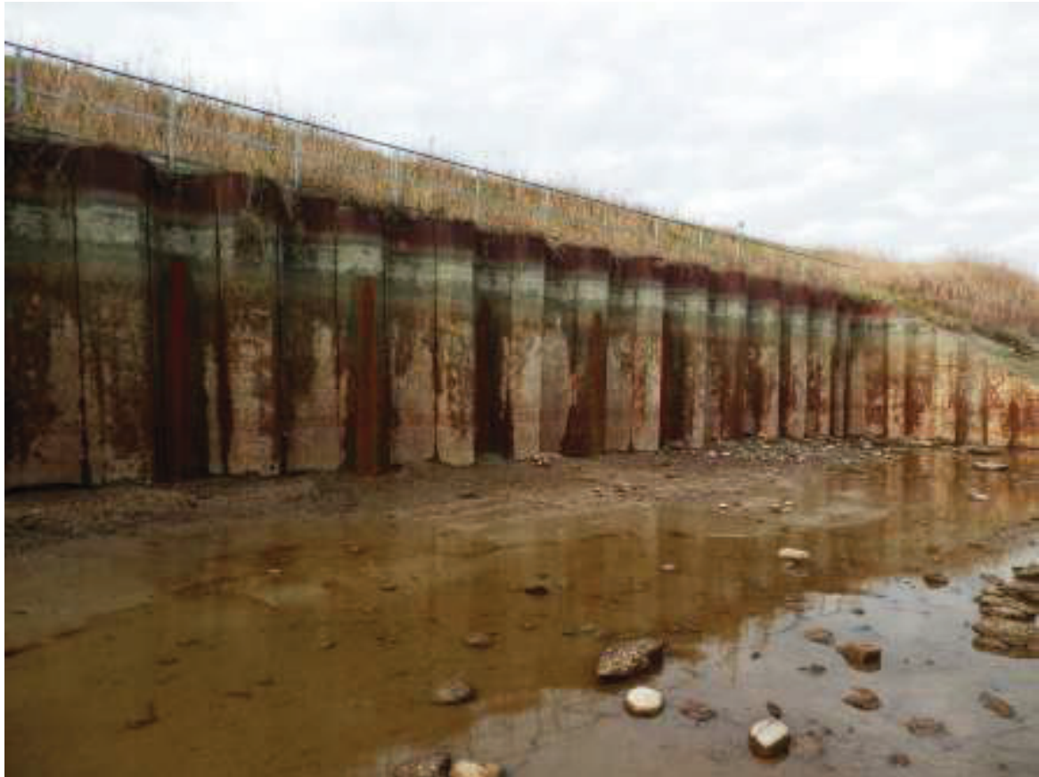
PALANCOLATO IN PROSSIMITA' DELLA NUOVA RAMPA
