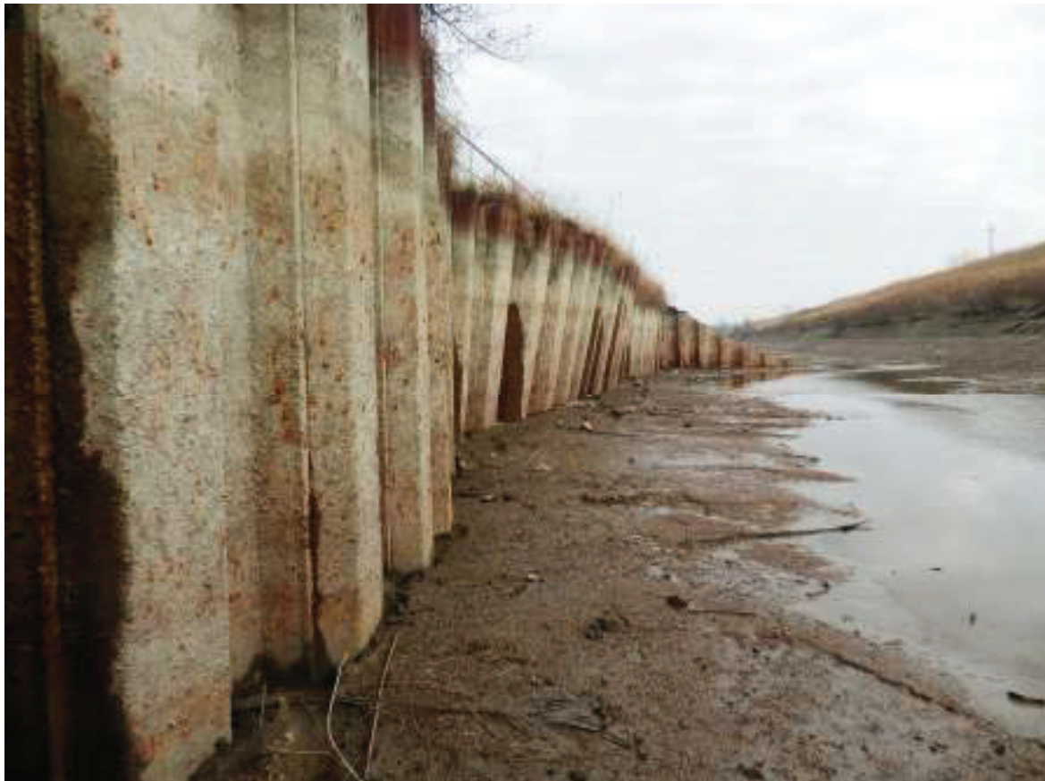
PALANCOLATO IN PROSSIMITA' DELLE TERRE RINFORZATE
