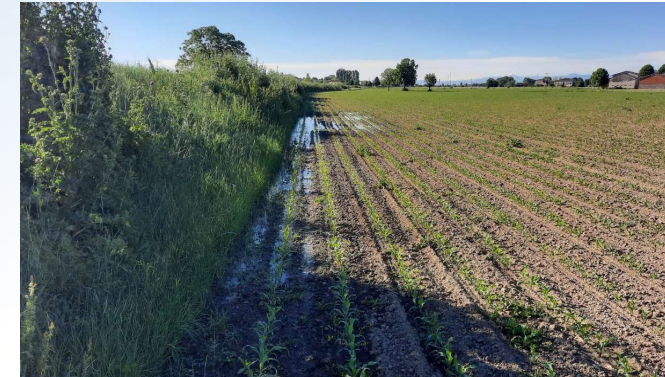
Segnalazione di allagamento causate da perdite arginali
