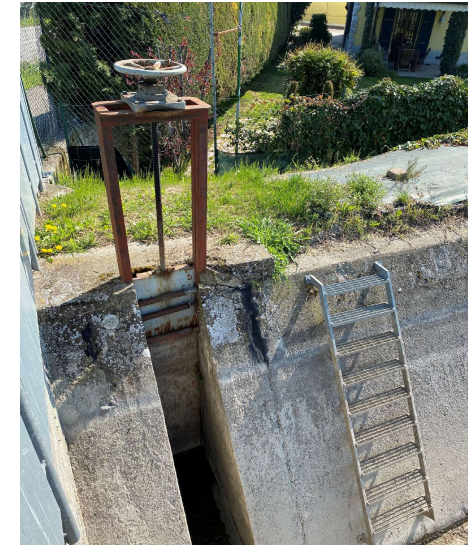
Paratoie di derivazione sul canale
