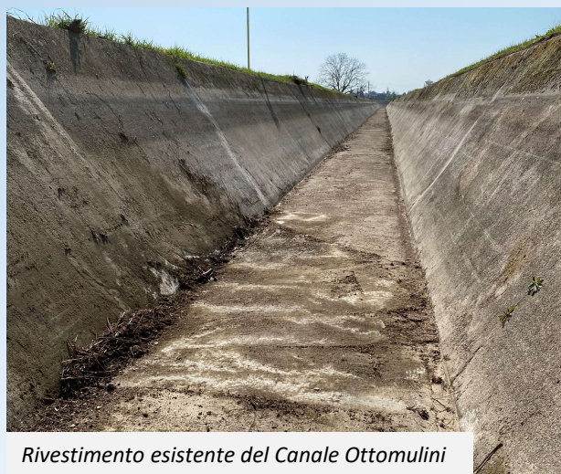
Rivestimento esistente del Canale Ottomulini
