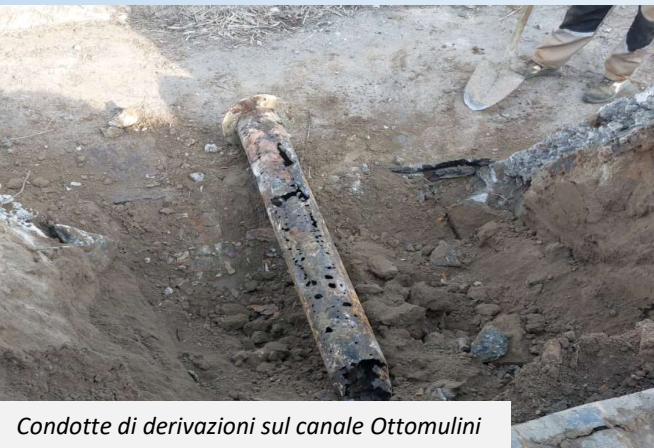
Rivestimento esistente del Canale Ottomulini
