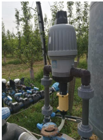
Fig. 5 – Particolare della pompa dosatrice impiegata nella prova.
