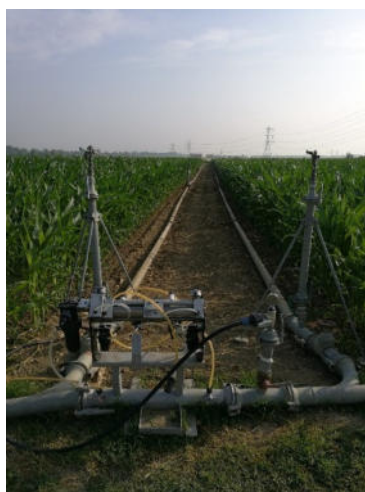
Fig. 5 – Particolare della pompa dosatrice impiegata nella tesi ad aspersione.
