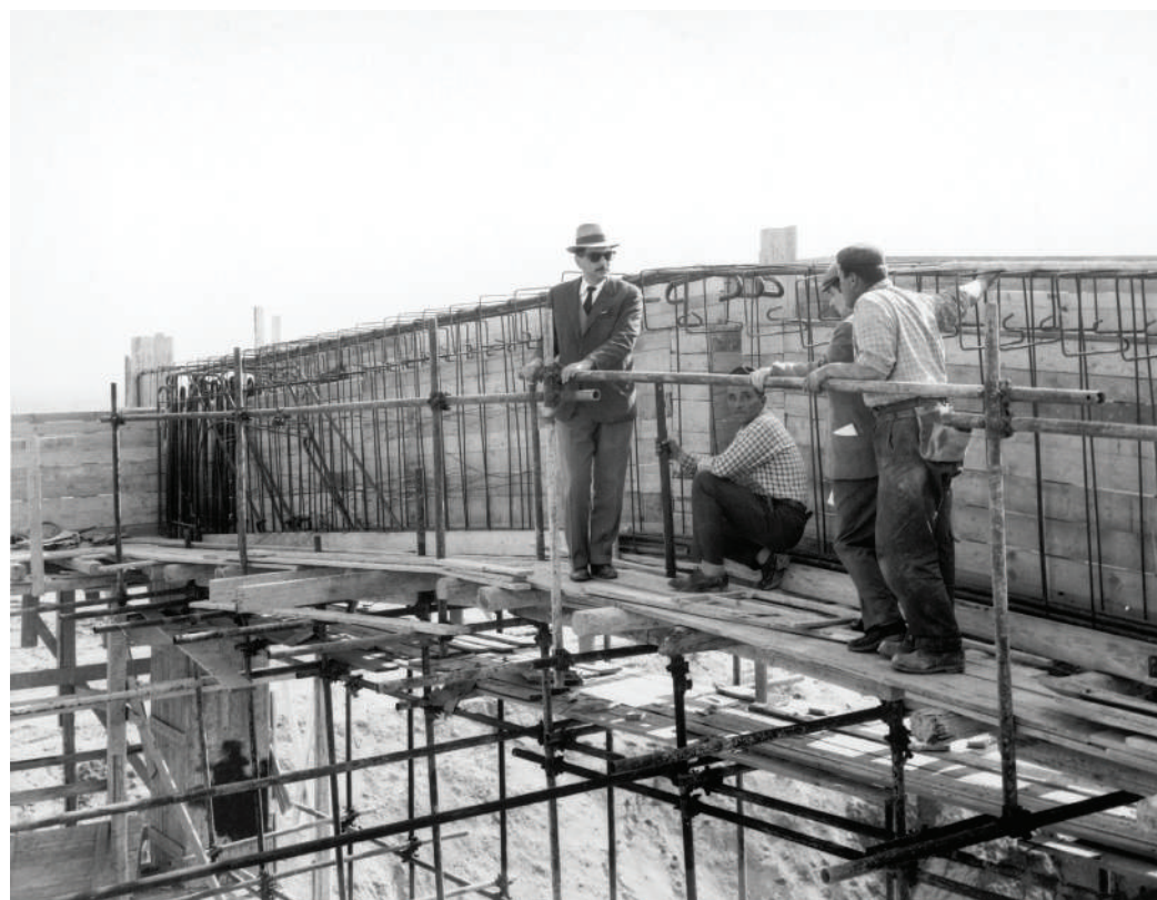
Impianto del Palantone sul fiume Po. Il Direttore dei lavori, ingegnere Ugo Chiodarelli, e operai al lavoro alla realizzazione dei portali, 1965 Archivio CER, foto Enrico Pasquali
