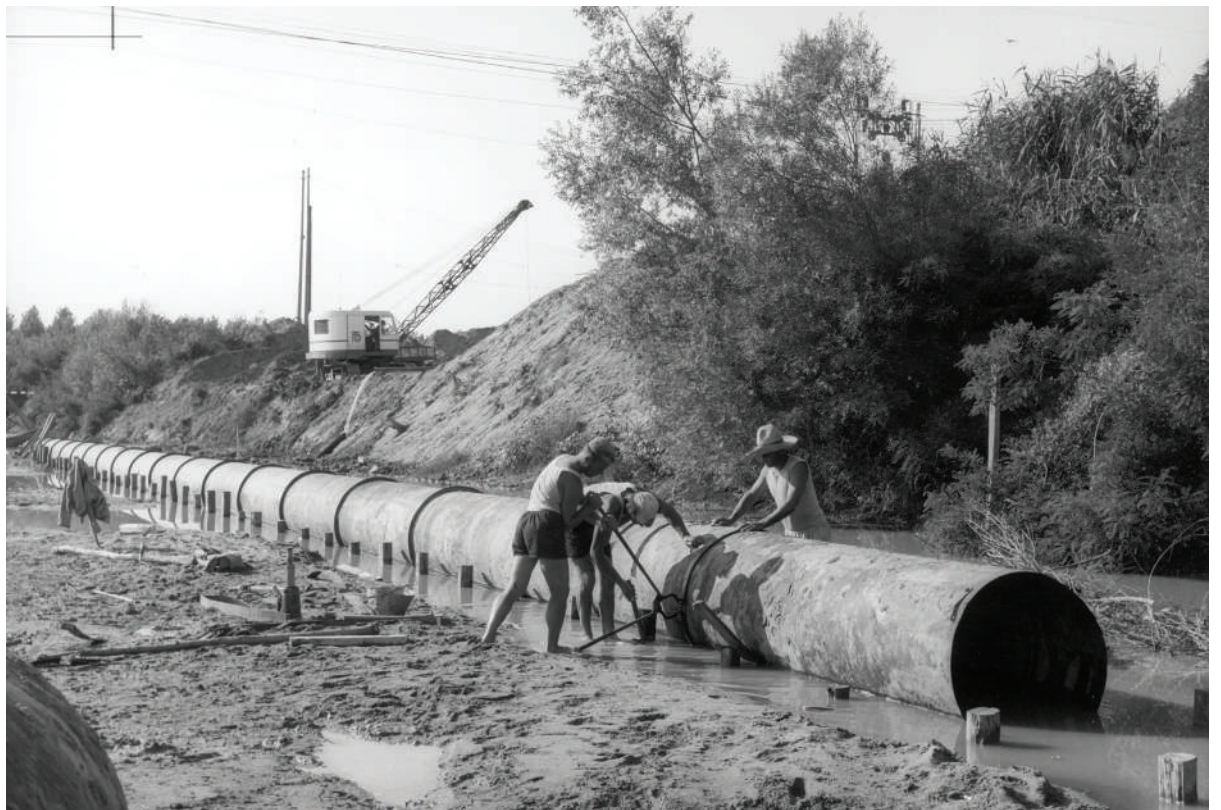
Lavorazione della Botte sotto il Reno. Posa dei tubi per la portata di magra del Reno, s.d. Archivio CER, foto Enrico Pasquali
