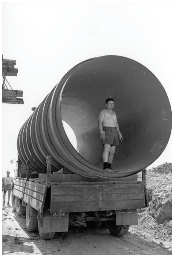
Impianto del Palantone. Operaio all'interno di uno dei tubi di aspirazione, 1967 Archivio CER, foto Enrico Pasquali
