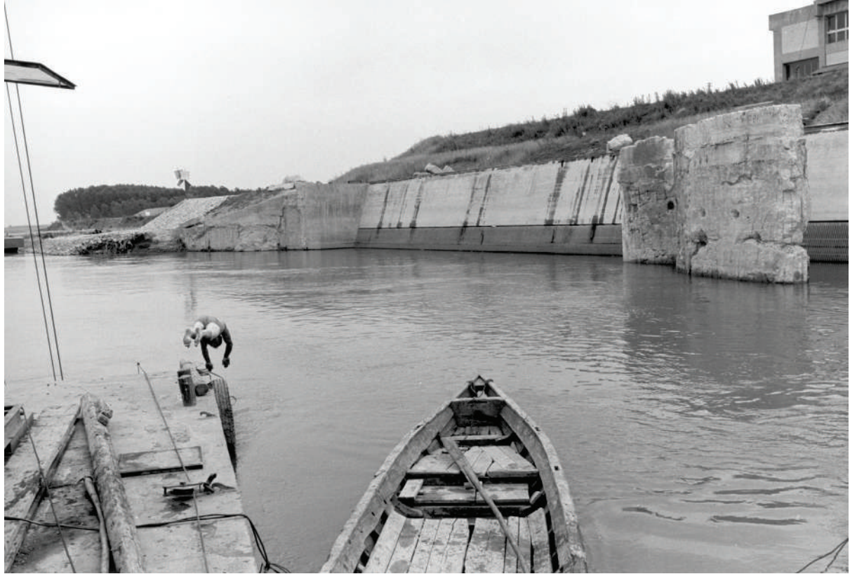
Impianto del Palantone. Un tuffo durante i lavori all'opera di presa, 1968
