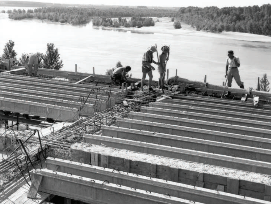
Impianto del Palantone. Operai al lavoro alla copertura del fabbricato, 1965 Archivio CER, foto Enrico Pasquali
